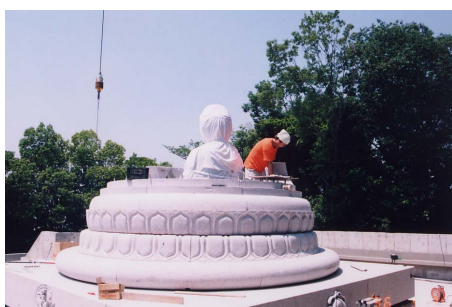
ストウパー組み上げ
